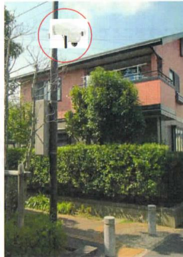
溶融亜鉛アルミニウム系合金めっき + ミディアムグレーメタリック塗装仕上げ
