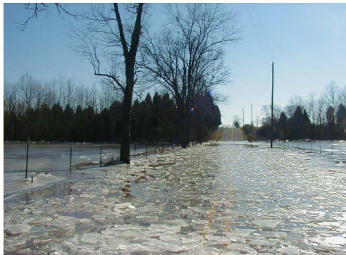
突然、道路が冠水していました。
