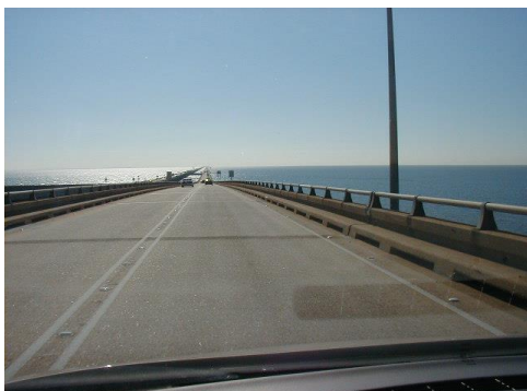
この橋の向こうがNew Orleans。橋の長さは40Km。通行料は3ドル
