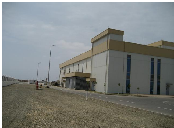
南側の壁(東側から)
