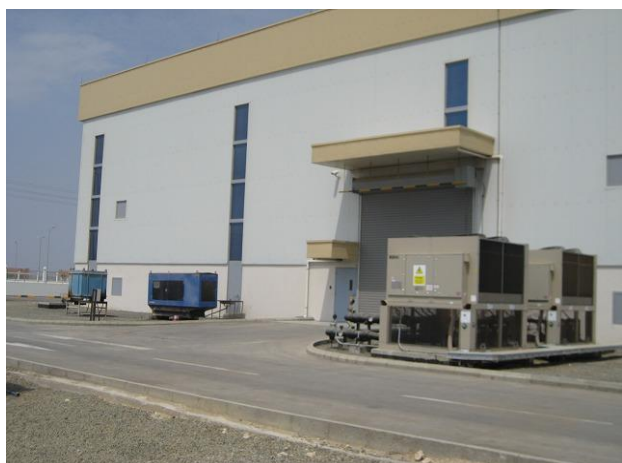
西側の壁(南側から)
