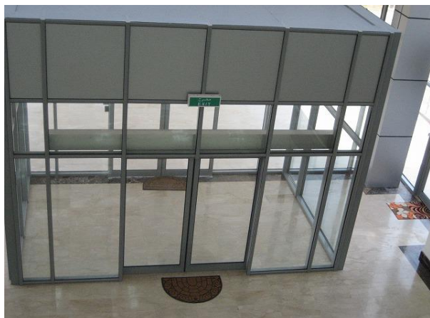
内側より入口付近 2F 廊下より
