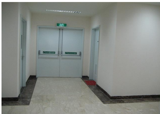
1F 廊下 センターから南
