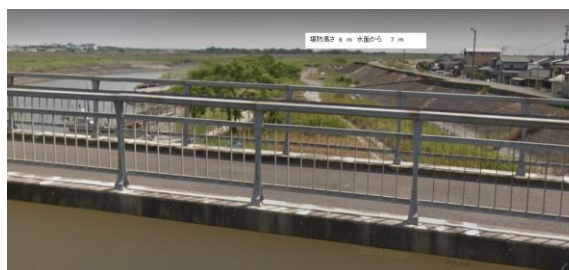
図 5-1 喜瀬川の堤防の高さ
