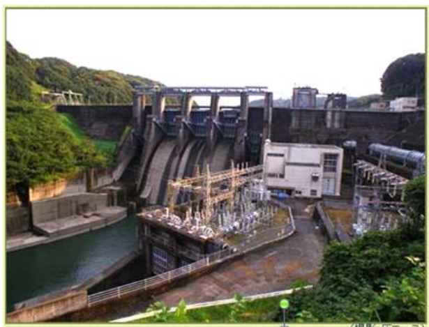
大淀川第一ダム
