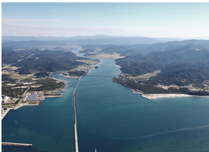
川内川河口域（薩摩川内市）
