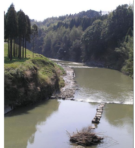
写真 6 夷隅川の土手例
