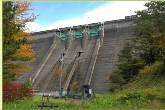
黒木ダム [岡山県] (くろぎ)
