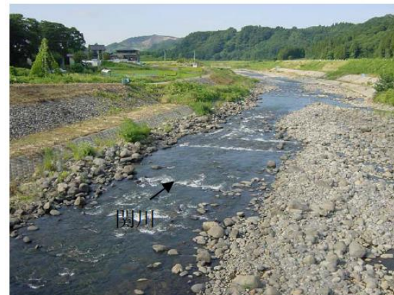
猿橋より下流を望む（妙高市）
