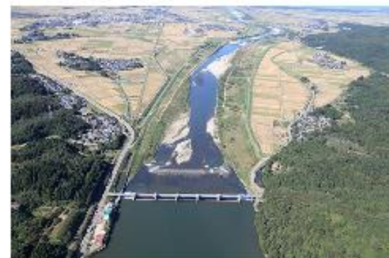
荒川頭首工付近(河口より8.0km付近)
