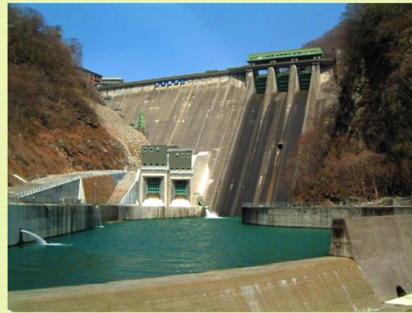
五十里ダム [栃木県] (いかり)
