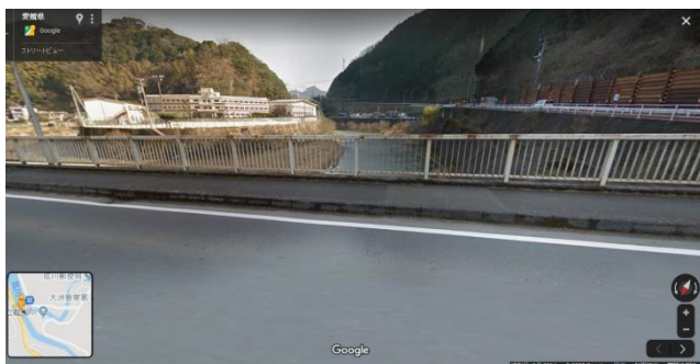
鹿野川ダム下あたりの河川の状況
