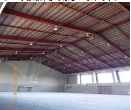
工事が終わった体育館内部
