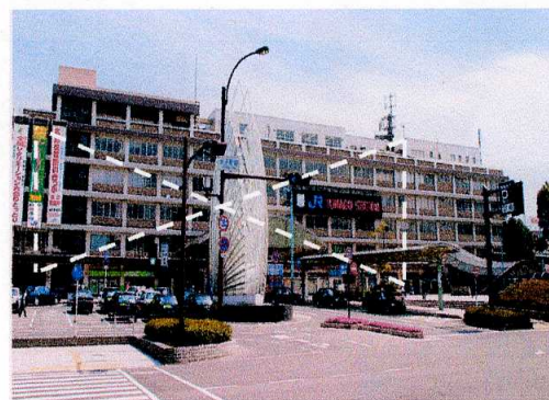
「歩道橋」の新設と工事現場の確保のために、駅舎の70%を取り壊す。
