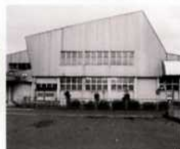
大谷町に新築移転が決まった米子市学校給食センター
