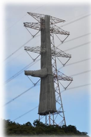
再塗装のための被い 高圧送電用鉄塔でした
