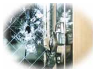
扉周辺のガラスを破壊 (警視庁のホームページより)
