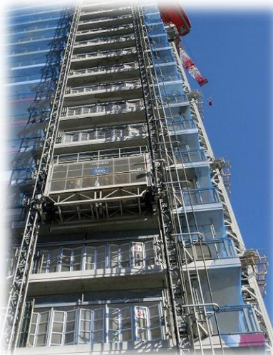
建設中のビルに取り付けられた作業用昇降機 (左下から三段目部分) と写真右はクレーン重機 (2012/12/16)
