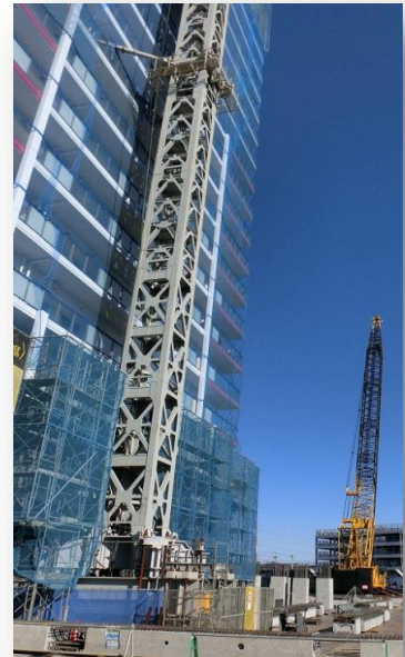
建設中のビルに取り付けられた作業用昇降機 (左下から三段目部分) と写真右はクレーン重機 (2012/12/16)
